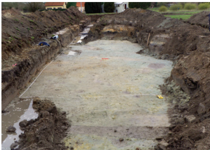
Figuur 9: Zicht op kijkvenster I
