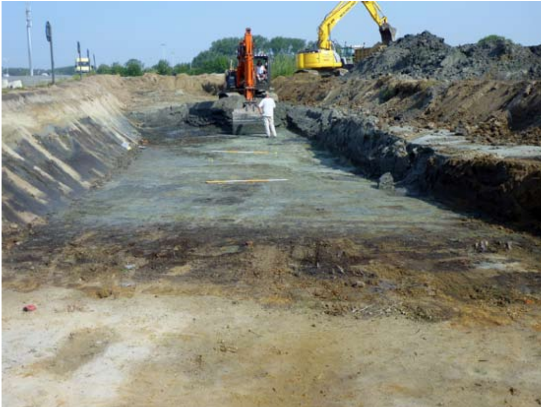
Figuur 7: Afgraven van een sleuf in het opgehoogde gebied, met duidelijk zicht op de blauwige verkleuring van de bodem
