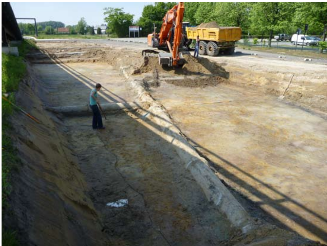
Figuur 55: Graafwerk op zone 5 brug noord, vlak naast de voorlopige brug
