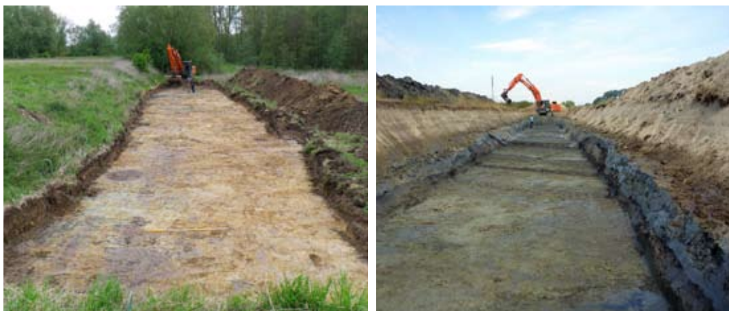
Figuur 5 en 6: Zicht op de aanleg van de sleuven in het lagergelegen stuk (links) en in het opgehoogde terrein (rechts)
