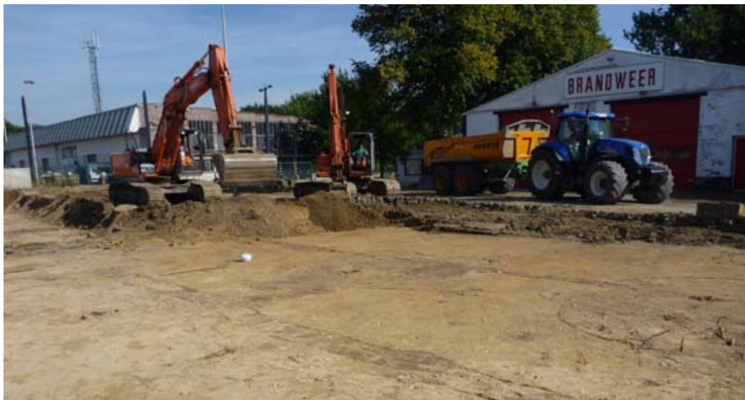
Figuur 22: Werkzaamheden aan de gang op zone 3 wegkoffer bis
