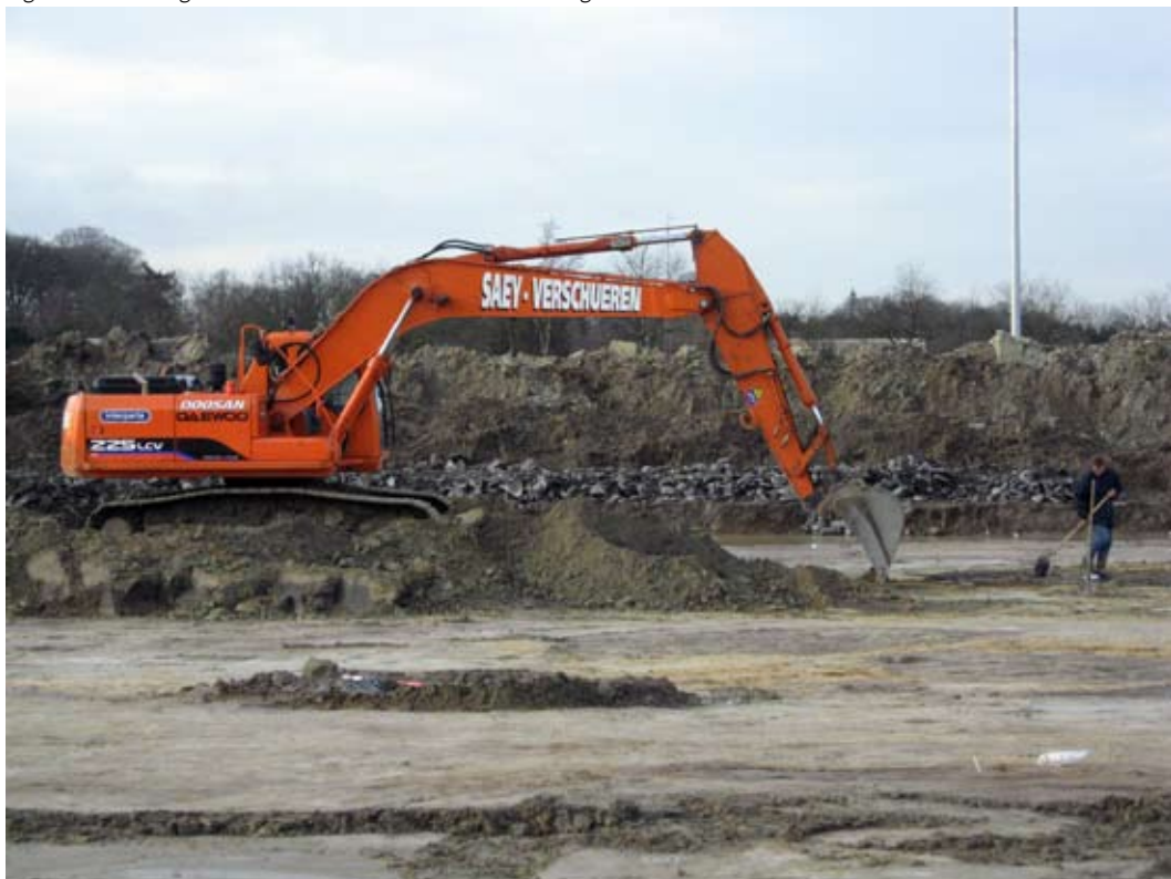
Figuur 3: Het afgraven met de kraan tot het archeologisch relevante niveau
