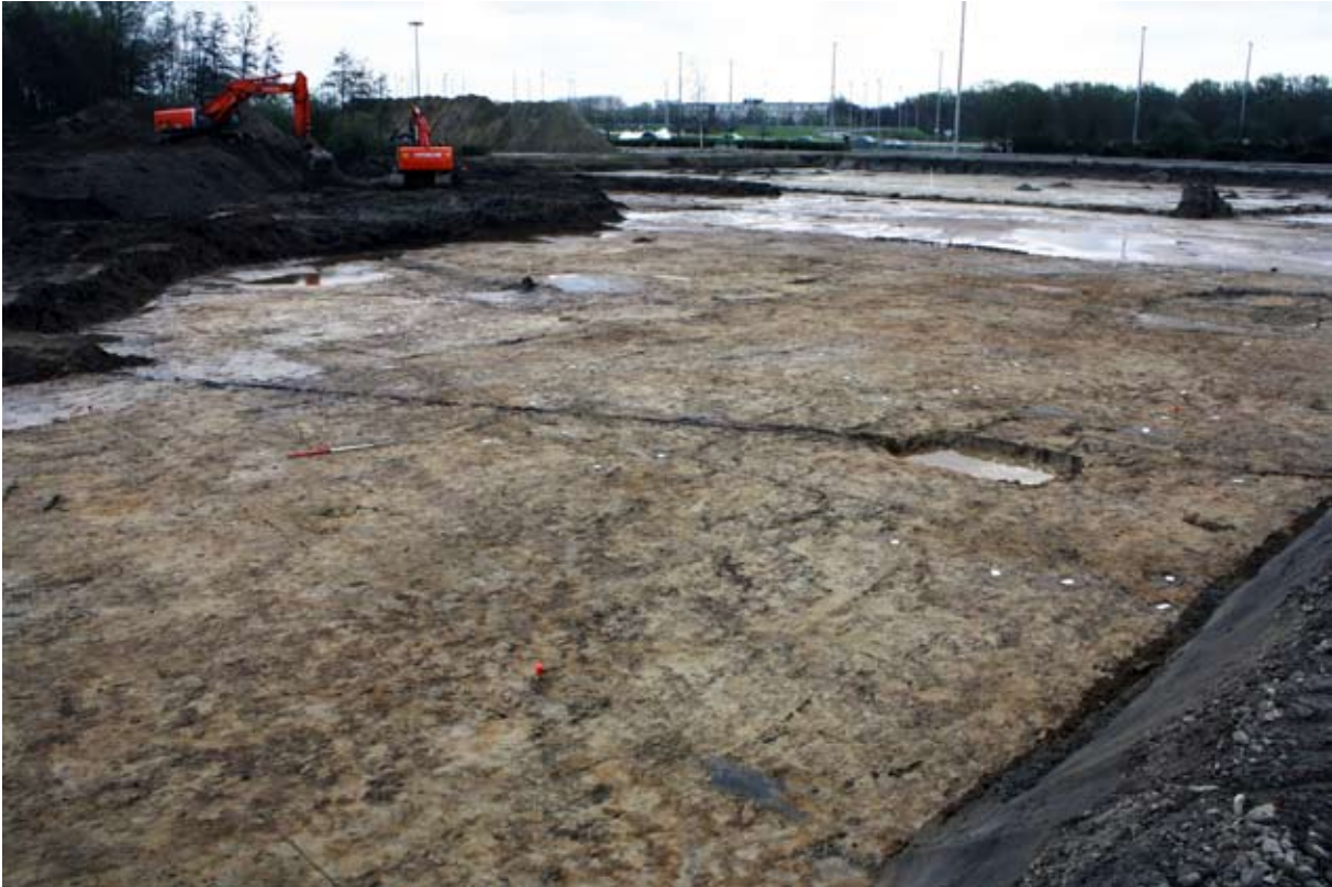
Figuur 150: Zicht vanuit het zuidwesten op de westelijke afbakening van erf 3.
