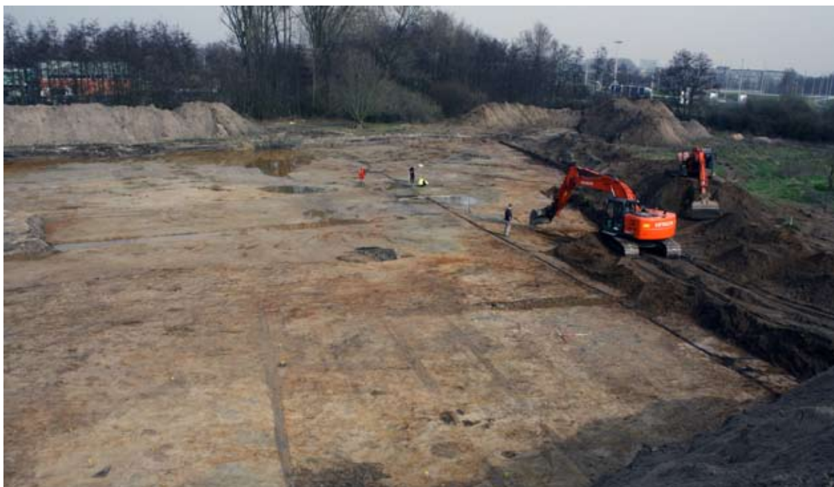
Figuur 7: Het aanleggen van het westelijke vlak met de graafkraan begeleid door het team.
